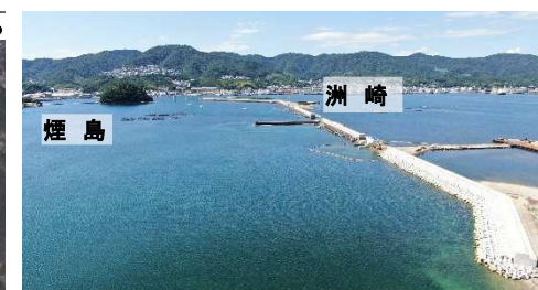
工事中の福良港湾口防波堤
